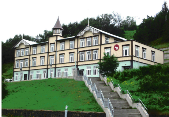
Mynd 27. Samkomuhúsið, byggt 1906. Ljósmynd B.J.
